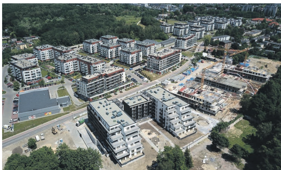
Osiedle Franciszkańskie i Franciszkańskie Południe w budowie
