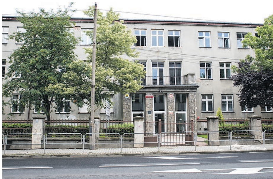
Budynek przy ul. Granicznej 27, w którym mieści się Centrum Usług Wspólnych
