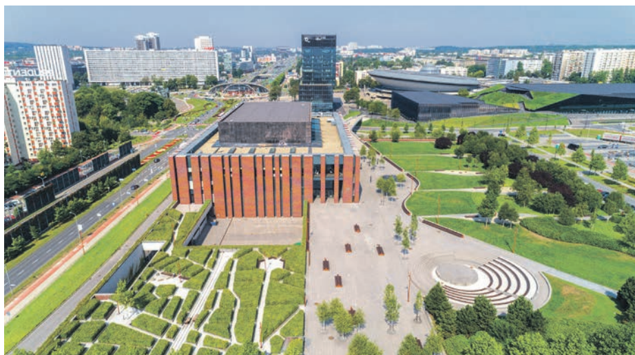
FOT. UM KATOWICE
