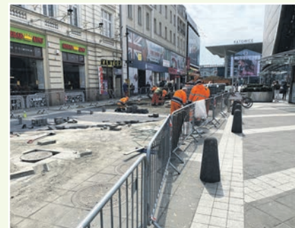
Przebudowa nawierzchni pl. Szewczyka
