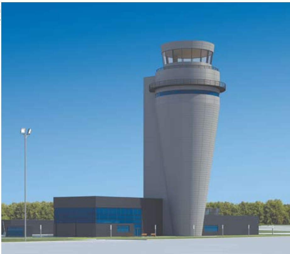
Wieża kontroli w Katowice Airport
