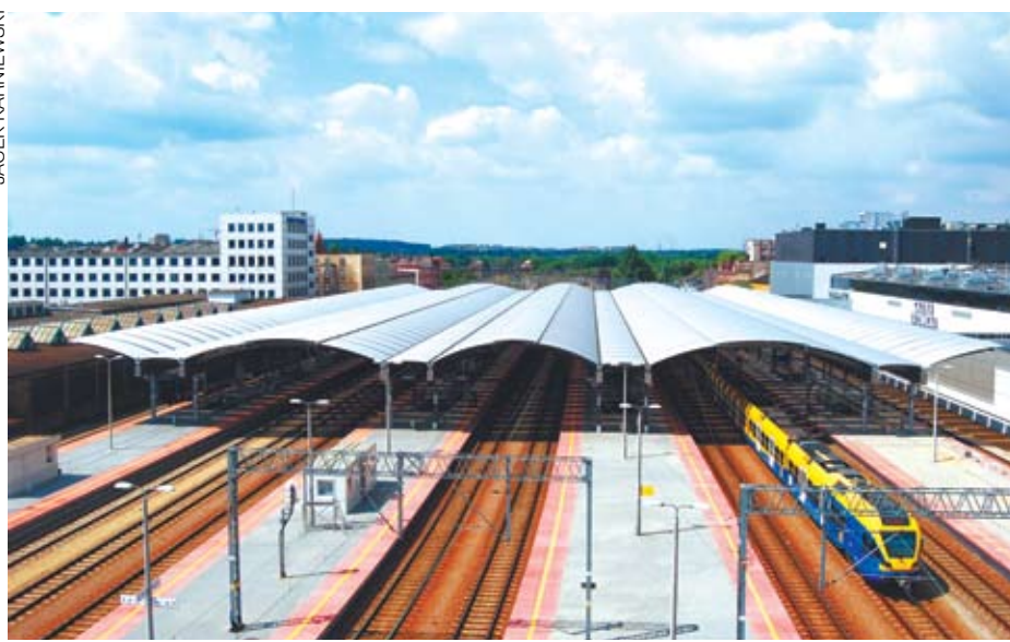
PKP dokonały kompleksowej modernizacji stacji wraz z zadaszeniem o długości 160 metrów
