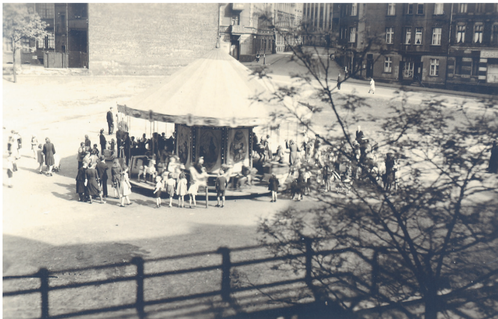
Obecny plac Oddziałów Młodzieży Powstańczej; widok z okna mieszkania na pierwszym piętrze przy dawnej Victoriastrasse 5a, 1942 r.
