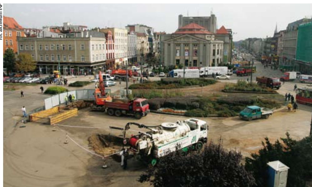
Prace remontowe, wrzesień 2008 rok
