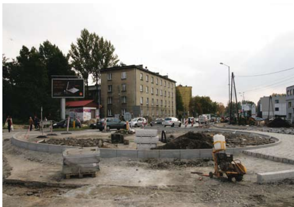
Budowa ronda w Ligocie, październik 2008
