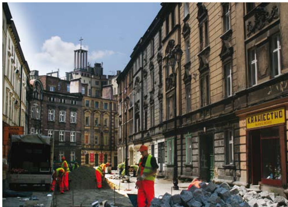
Przebudowa ulicy Krzywaj, czerwiec 2008
