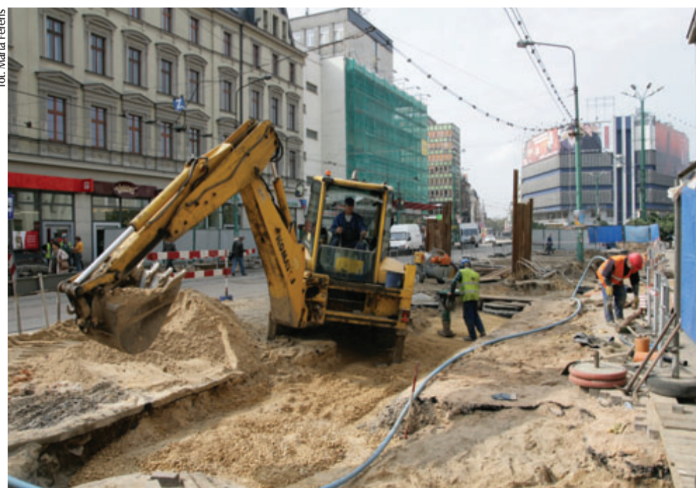
Prace kanalizacyjne w ciągu ulicy Warszawskiej
